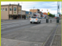
Green Roadway S. Tacoma Way S. 52nd— S. 56th St City of Tacoma
